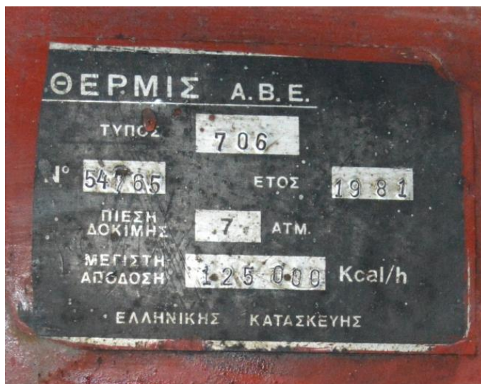
Εικόνα 3.15: Χαρακτηριστικά Καυστήρα Πετρελαίου
