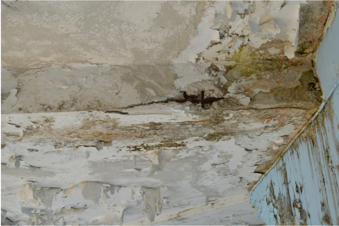
Εικόνα 3.10: Οπλισμός Πλάκας Σκυροδέματος Οροφής
