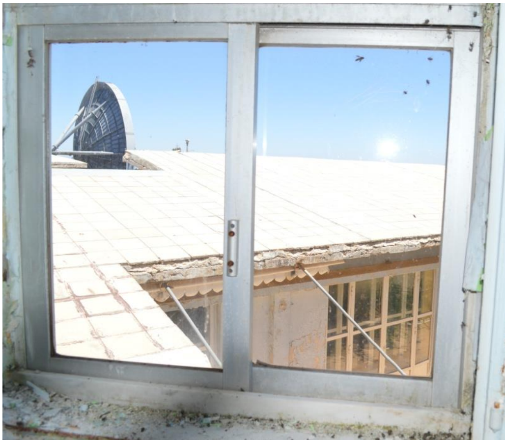
Εικόνα 3.12: Κούφωμα αλουμινίου με μονό υαλοπίνακα 3mm
