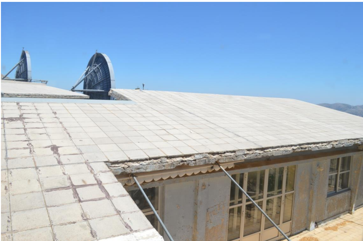
Εικόνα 3.11: Οροφή καλυμμένη με πλάκες πεζοδρομίου
