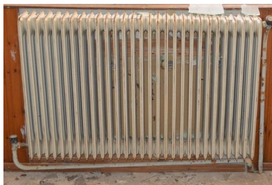
Εικόνα 3.17: Μονάδα Απόδοσης Θερμότητας
